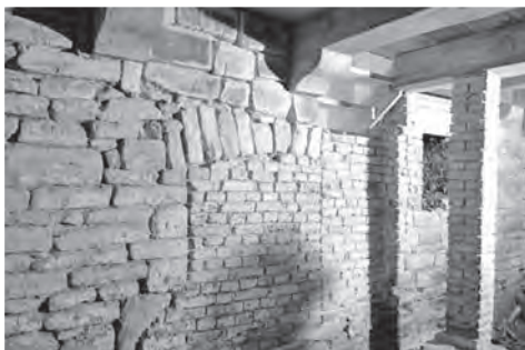
Im Keller: auf diese steinernen Sockel standen Pfeiler, die die alte Decke stützten.
