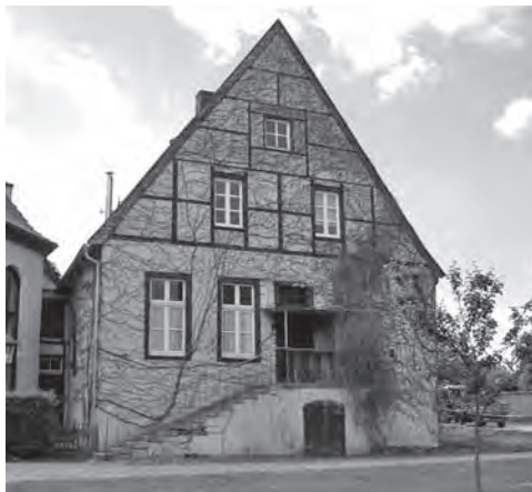
Zustand vor dem Umbau 2009
